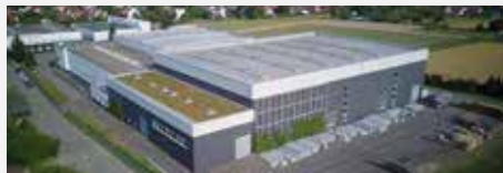
Hugo Brennenstuhl GmbH & Co. KG Werk 2 / Plant 2
